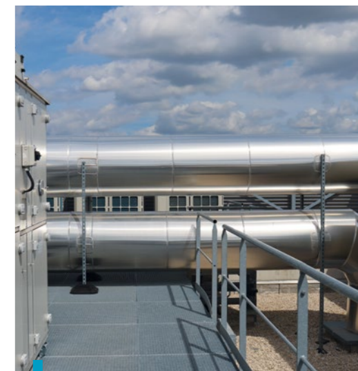
Installation d'équipements performants en toiture d'UPLINE
